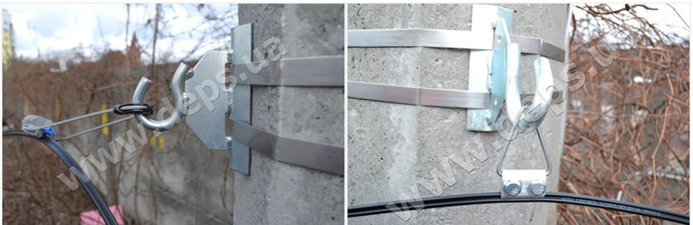
**Пример использования крюка для опор без отверстий Sicame GH016 вместе с [поддерживающим зажимом Crosver SSO](#):**
