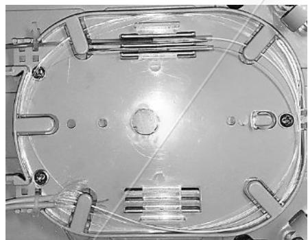
5.3.2. Зваріть волокно лінійного кабелю з волокном відповідного абонентського кабелю згідно з інструкцією на зварювальний апарат. Захистіть місце зварювання термоусаджувальною гільзою КДЗС.
